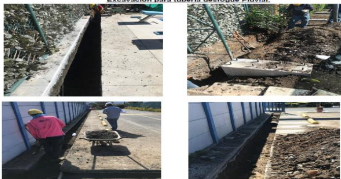
Instalación de tubería desfogues pluvial.
